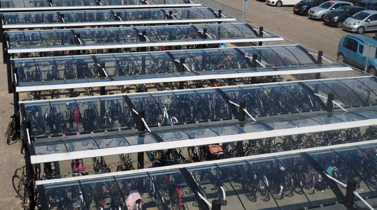
Asemien pysäköintiratkaisujen on oltava laadukkaita, runkolukittavia, sääsuojattuja ja määrältään riittäviä.
