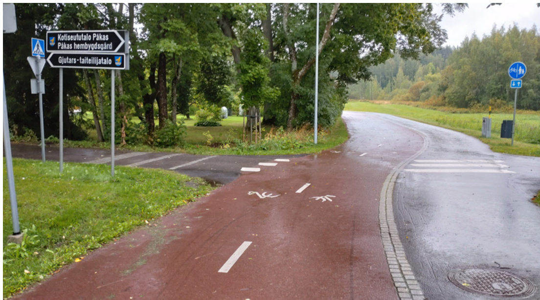
Tikkurilan-Hakunilanbaanan alkuosuus on valmiina.
