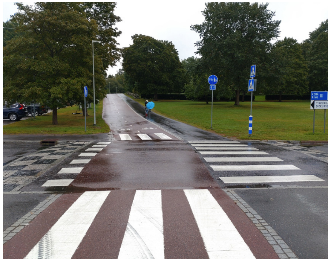
Kuninkaalantien ylitys Tikkurilassa.
